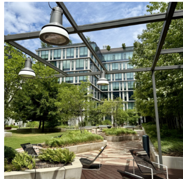
Le bureau de CAE à Budapest se trouve maintenant dans un nouveau bâtiment certifié LEED Or.
